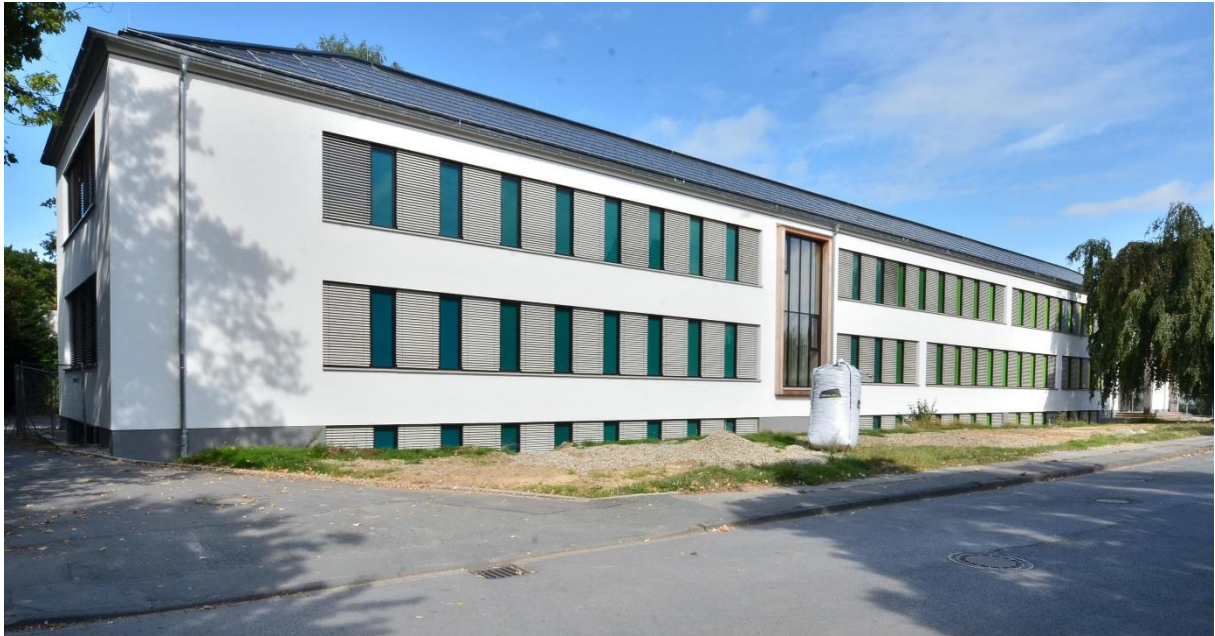
Gebäude 1 nach der Sanierung, Ansicht Dietrich- Bonhoeffer Str. Quelle: pape oder semke ARCHITEKTURBÜRO
