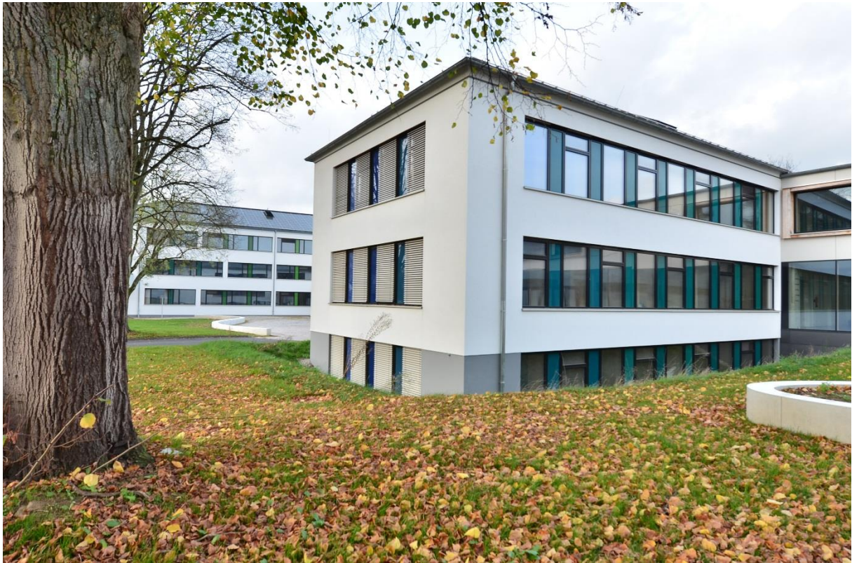
Gebäude 2 nach der Sanierung, Ansicht mit großformatigeren Unterrichtsfenstern Quelle: pape oder semke ARCHITEKTURBÜRO
