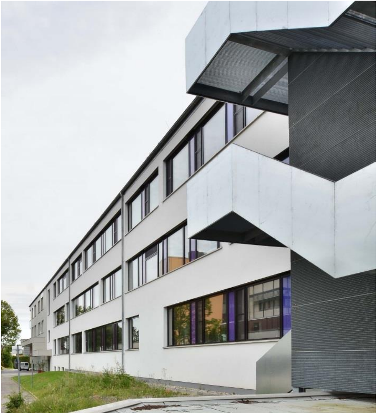
Gebäude 3 nach der Sanierung, Südwestansicht mit neuer Fluchttreppe Quelle: pape oder semke ARCHITEKTURBÜRO
