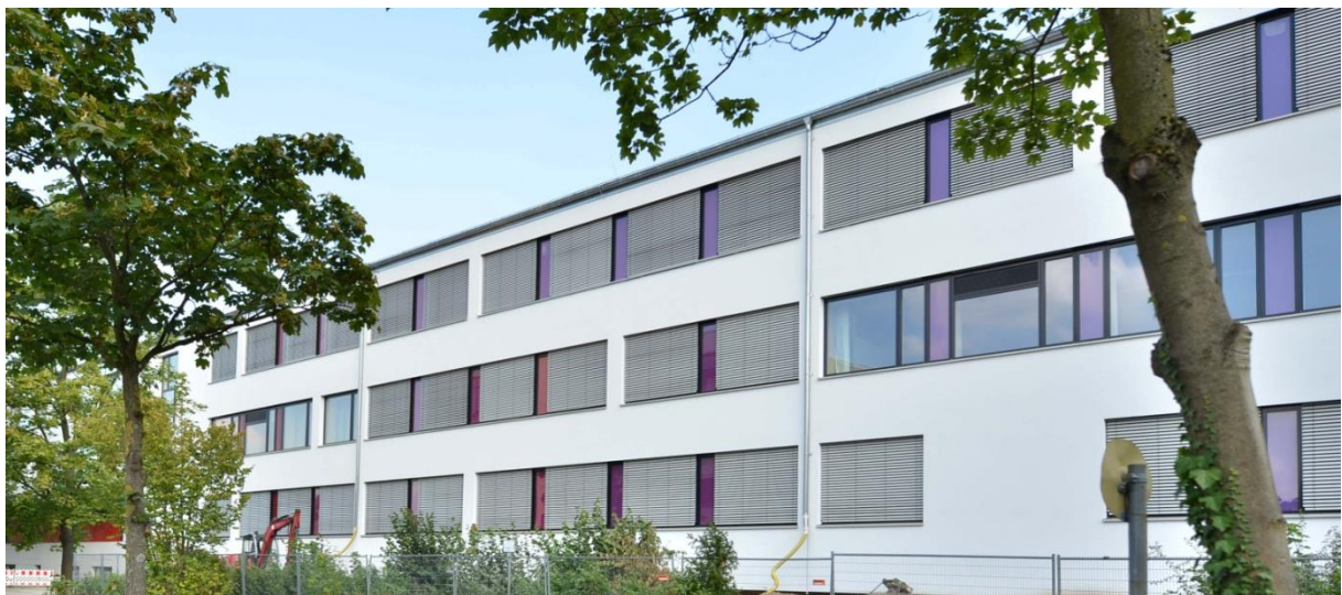
Südwestansicht Gebäude 3 nach der Sanierung Quelle: pape oder semke ARCHITEKTURBÜRO
