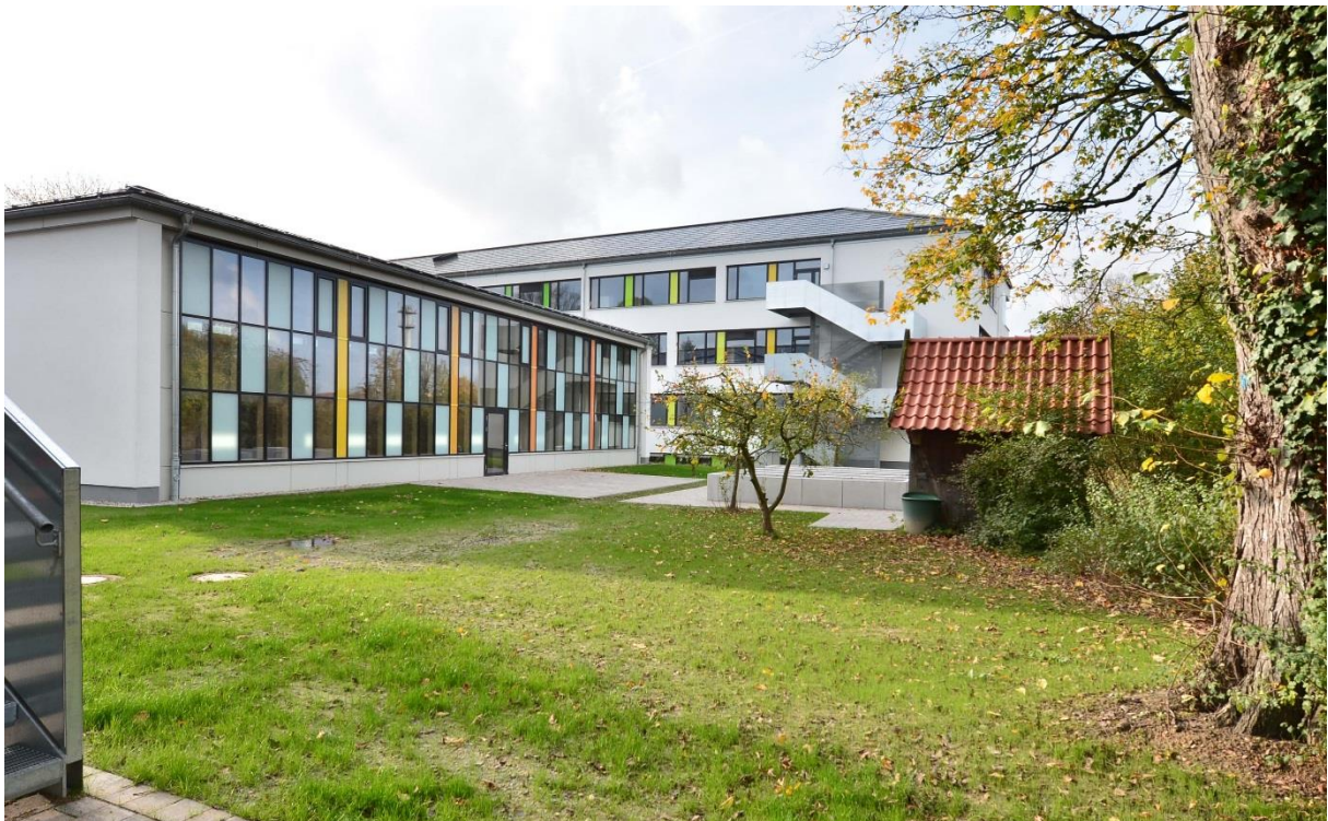
„Kleine Turnhalle“ nach der Sanierung Quelle: pape oder semke ARCHITEKTURBÜRO
