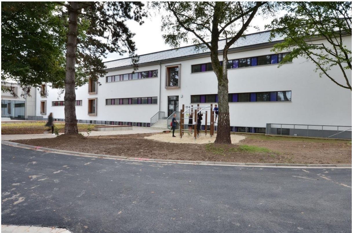
Gebäude 1 nach der Sanierung, Ansicht Innenhof Quelle: pape oder semke ARCHITEKTURBÜRO
