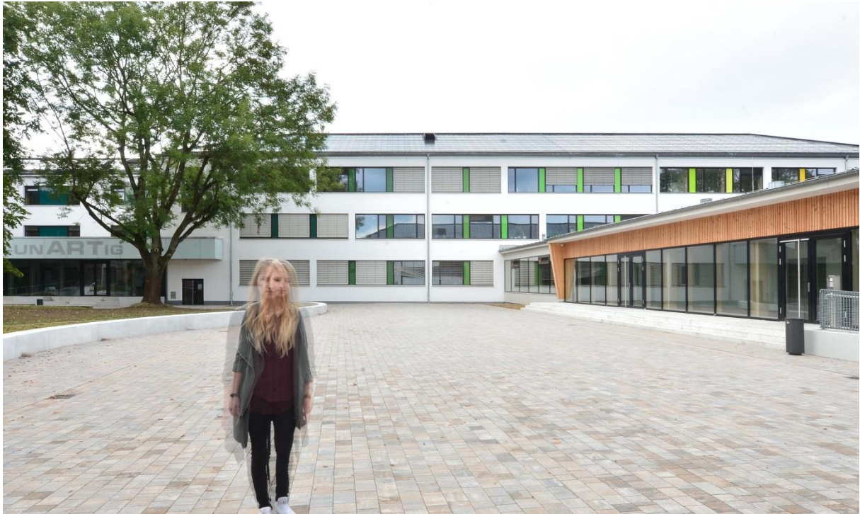
Gebäude 3, Schulhof mit Pausenhalle vor der Kleinen Turnhalle Quelle: pape oder semke ARCHITEKTURBÜRO
