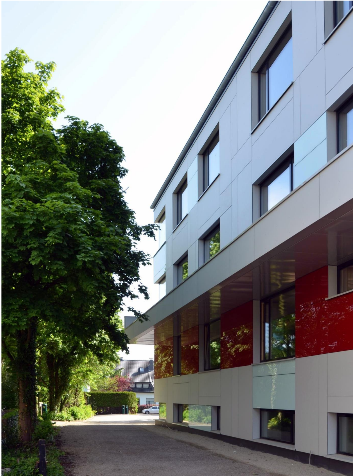
Erweiterungsbau Lehr- und Verwaltungstrakt Quelle: pape oder semke ARCHITEKTURBÜRO
