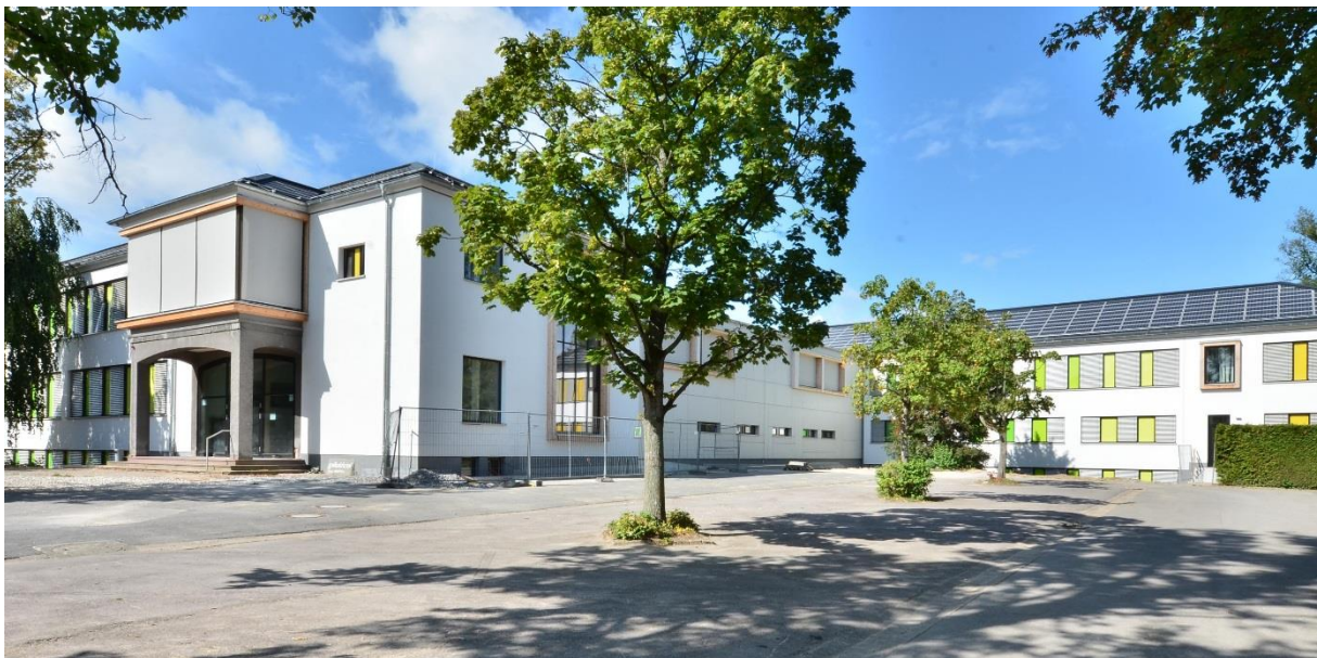
Gebäude 1 Haupteingang, Dietrich- Bonhoeffer Str. Quelle: pape oder semke ARCHITEKTURBÜRO
