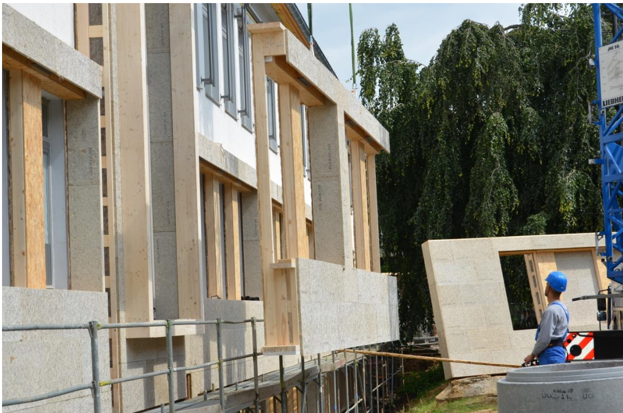
Gebäude 1, Montage der nach 3-d-Scan vorgefertigten Holzbauelemente zur Fassadensanierung, Quelle: pape oder semke ARCHITEKTURBÜRO
