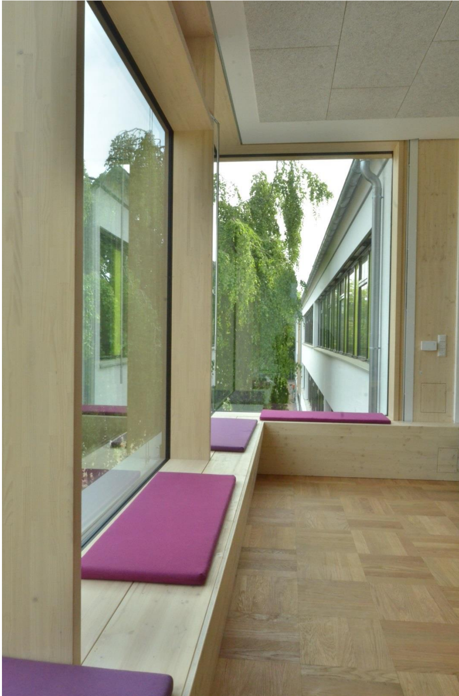
Gebäude 1 nach der Sanierung, Ansicht Innenhof Quelle: pape oder semke ARCHITEKTURBÜRO
