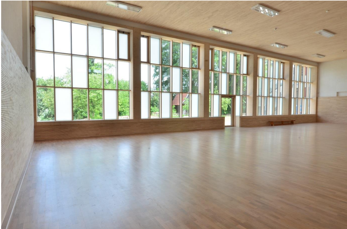
Innenraum „Kleine Turnhalle“ nach der Sanierung Quelle: pape oder semke ARCHITEKTURBÜRO
